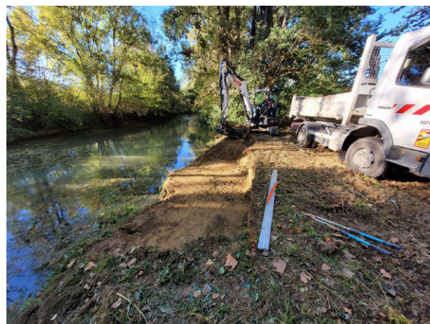
Date: 04/10/2022 Auteur(s): FDAAPPMA82 Localisation: Labourgade bief lentique et poste de pêche
